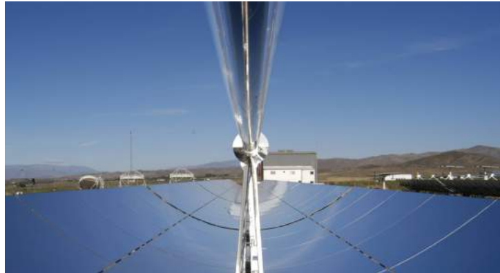
Figura 21: Tubo absorvedor integrado a um coletor cilíndrico parabólico
