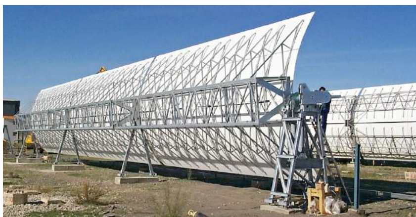
Figura 14: Módulo de uma estrutura de treliça espacial da Eurotrough
