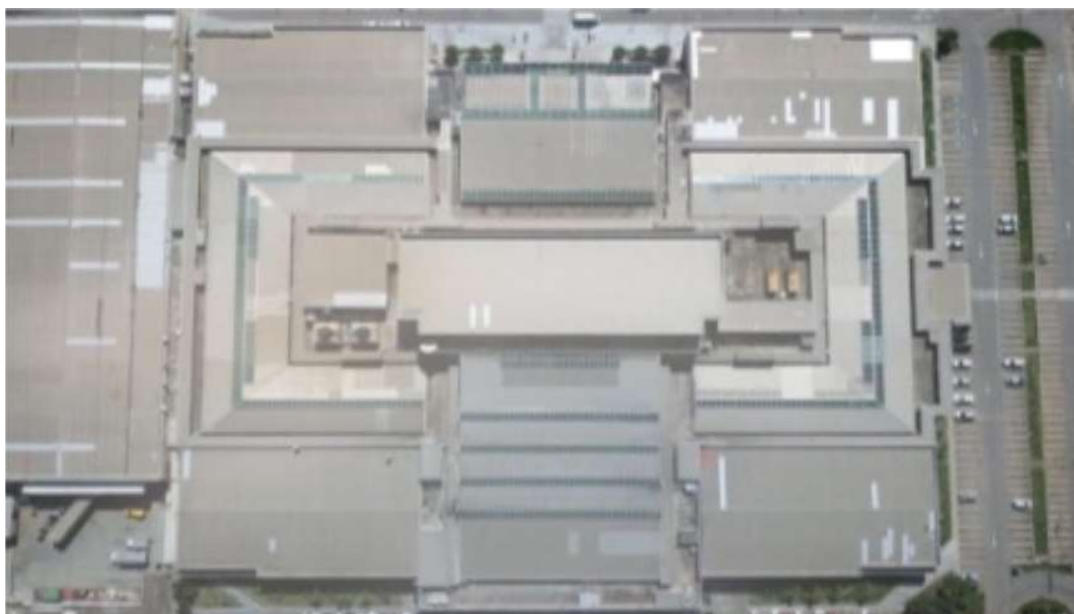
Figura 13 – Foto aérea da cobertura do shopping center
