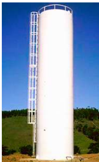
Figura 26 – Reservatório cilíndrico tubular
