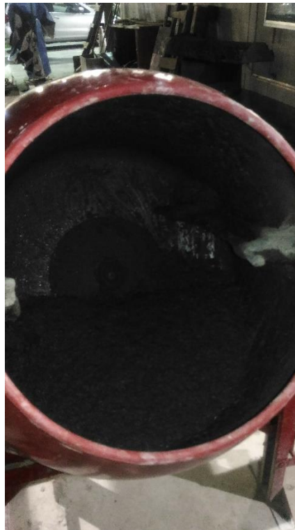
Figura 33 - Mistura do concreto na betoneira.
