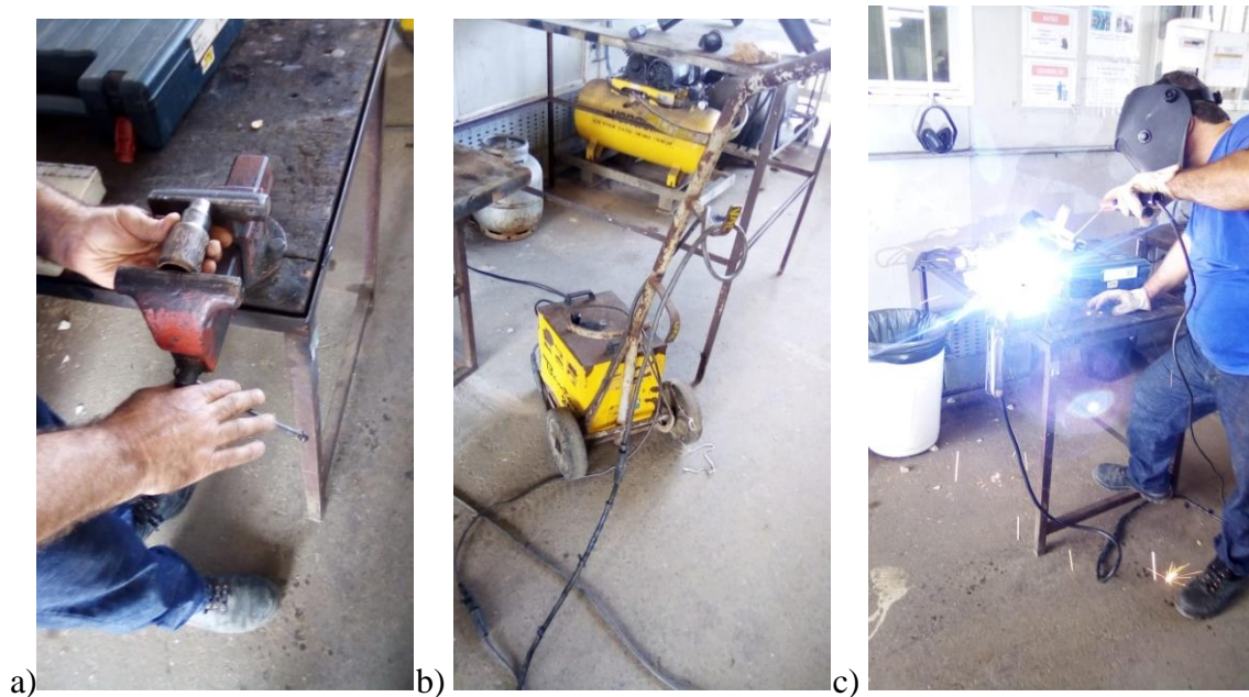
Figura 3.14 – a) Posicionamento das peças na morsa de bancada. b) Máquina de solda elétrica Bantam 200A utilizada. c) Realização da solda.
