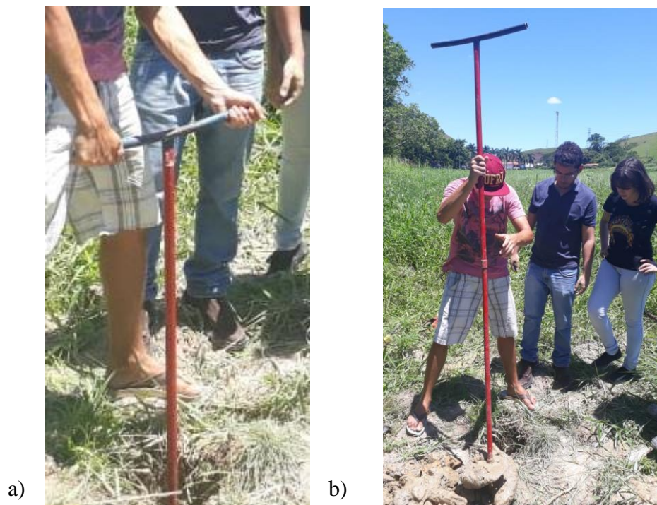
Figura 2.4 – a) Procedimento de rotação do trado manual e b) Retirada do material escavado.
