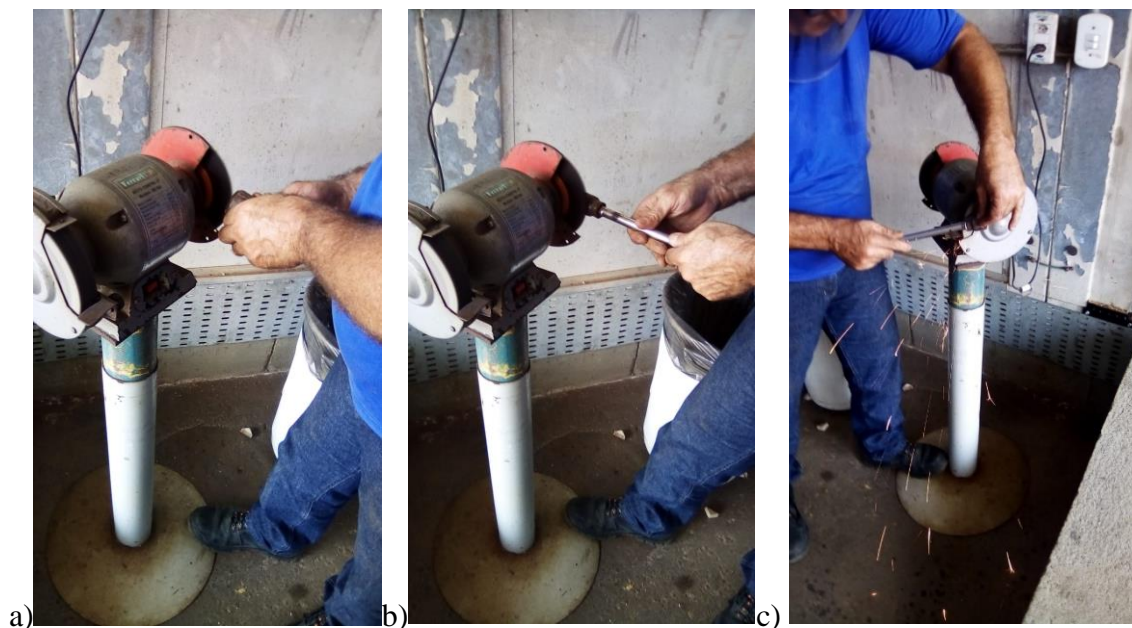
Figura 3.13 – a) Regularização e limpeza da luva na moto-esmeril de bancada. b) e c) Regularização e limpeza do soquete no moto-esmeril de bancada.
