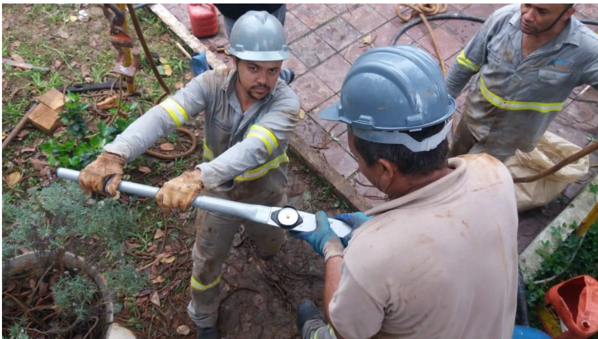
Figura 2.16 – Aplicação e leitura do torque em campo.
