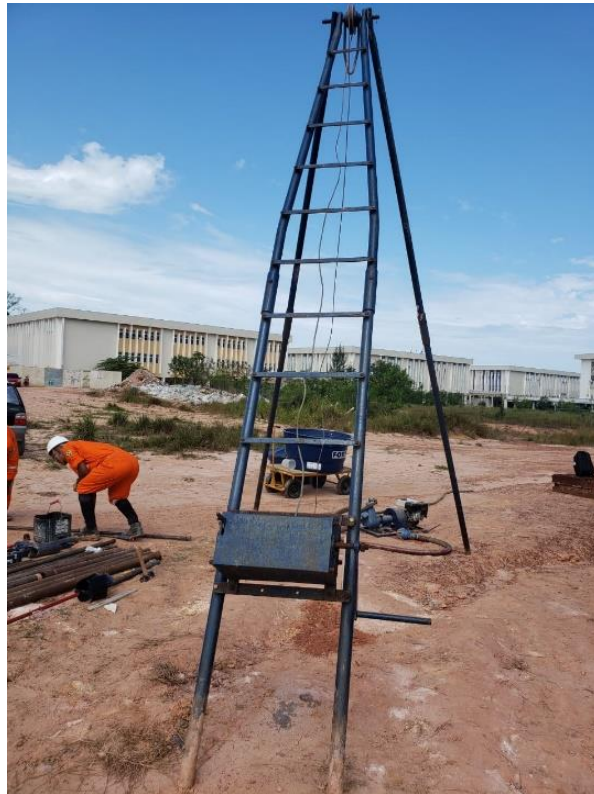
Figura 3.3 – Tripé de sondagem.
