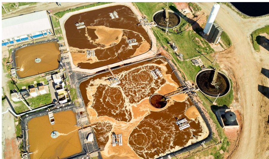
Figura 7. Foto aérea dos tanques de tratamento biológico da Estação de Tratamento de Chorume da CTR-Rio de Set/2017.
