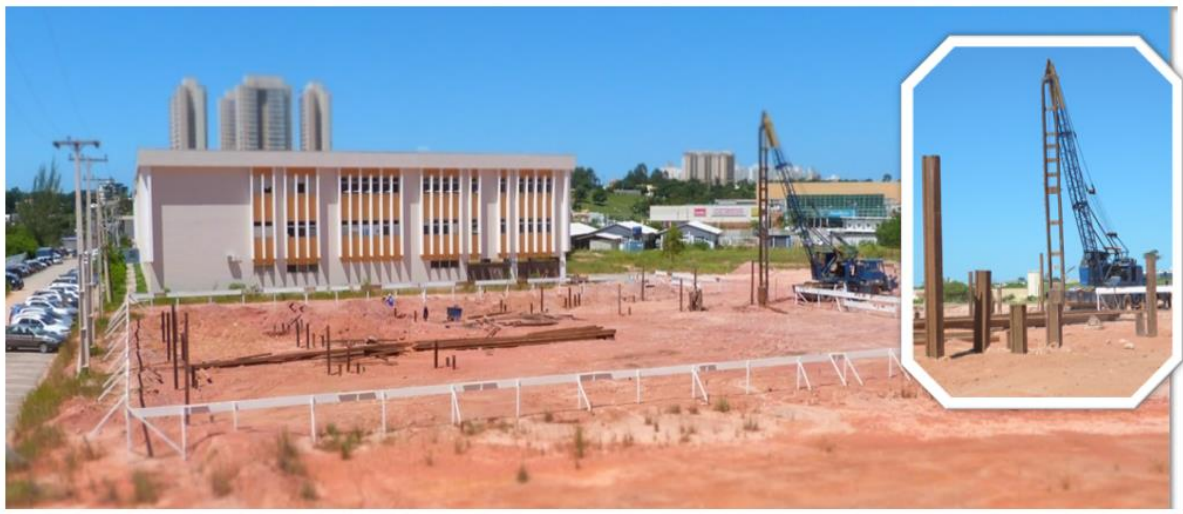
Figura 3.3 - Terreno do Bloco D da Cidade Universitária de Macaé, meados de 2018, quando da execução das fundações com bate-estacas.
