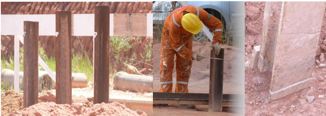
Figura 3.20 – Demarcação para arrasamento das estacas do bloco D (2018).
