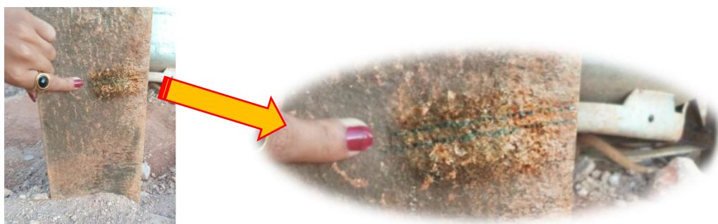
Figura 2.5 – Detalhe da marcação dos dois riscos de medida de nega do Trilho TR-57 do bloco D – Medida simples da nega (2018).
