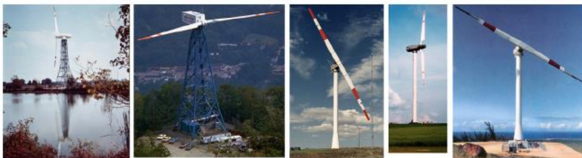
Figura 1.12 – Aerogeradores produzidos a partir da parceria NASA/DOE, da esquerda para a direita Mod-0, Mod-1, Mod-2, WTS-4 e Mod-5; NASA (2014).
