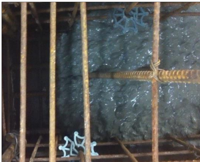
Figura 30 - Detalhe do concreto chegando na extremidade da viga.
