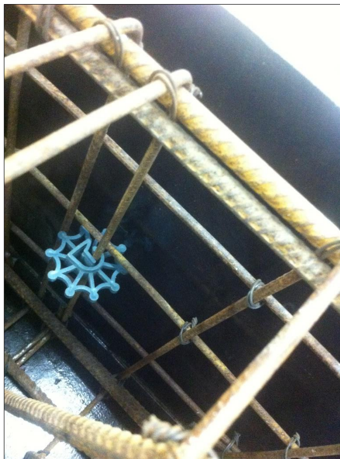
Figura 28 - Detalhe do espaçamento da armadura.
