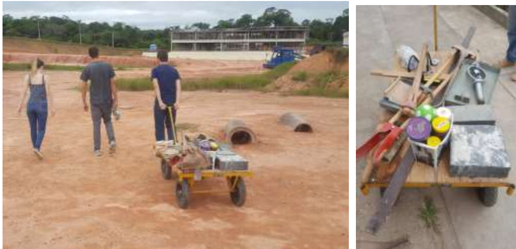
Figura 4.36 – Transporte das ferramentas auxiliares à montagem das provas de carga.
