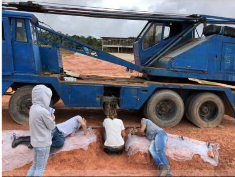
Figura 4.43 – Visão geral de uma prova de carga.
