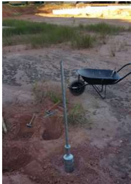
Figura 4.13 – Cravação do cilindro no solo.
