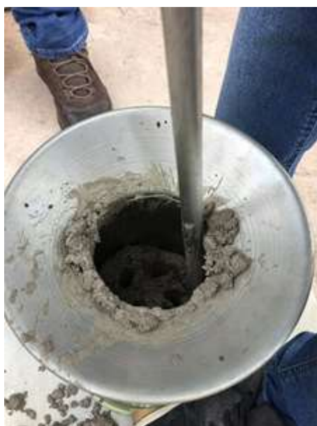
Figura 4.25 – Concreto sendo adensado.
