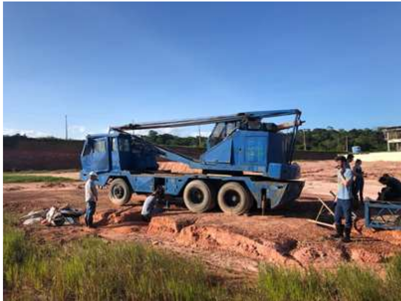
Figura 5.6 – Momento em que a capacidade de carga do sistema de reação foi esgotada durante a prova de carga com a placa de 26 cm de diâmetro.
