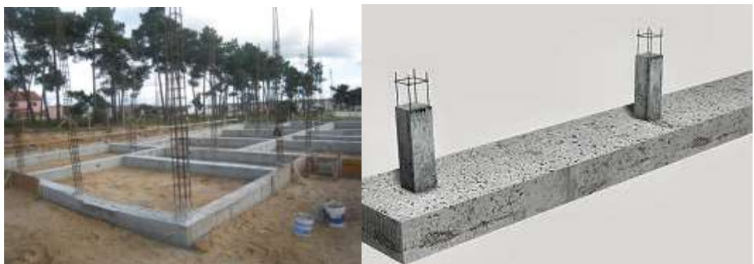
Figura 2.5 – Exemplos de vigas de fundação (Internet)
