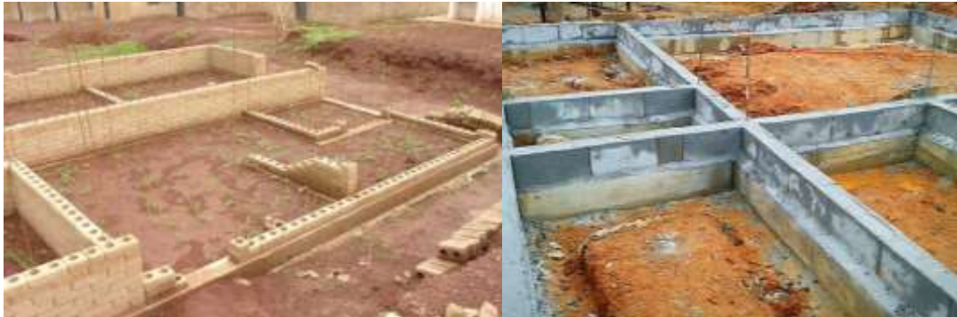
Figura 2.4 – Exemplos de sapatas corridas (Internet).
