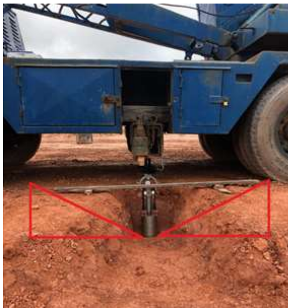
Figura 4.42 – Espaço entorno da placa sem sofrer acréscimo de tensão durante a realização da prova de carga.
