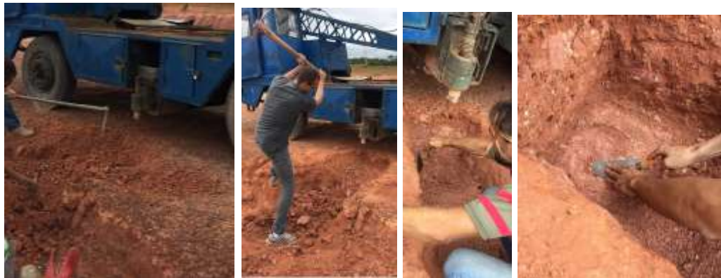
Figura 4.37 – Sequência da limpeza da camada superficial desprezada.
