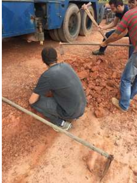
Figura 4.2 – Declive e camada superficial sendo retirada.
