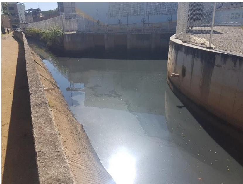
Figura 27: Estação de Bombeamento (Construção Azul)
