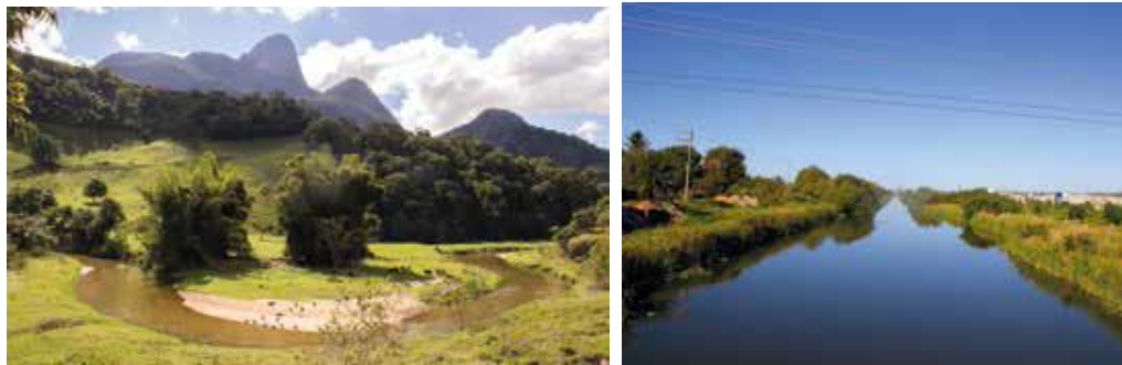
Figura 7: Curva do rio Macaé em sua parte inferior, antes da retificação à esquerda e depois da retificação à direita
