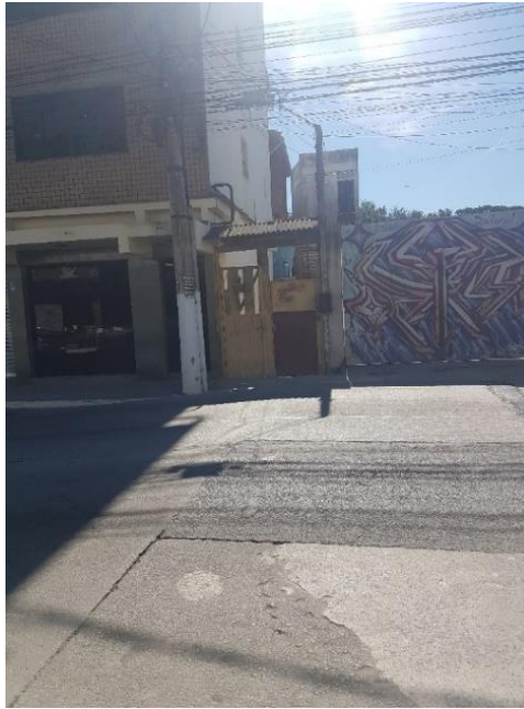
Figura 29: Rua Télió Barreto, vista da casa de controle hidráulico da desembocadura número 776
