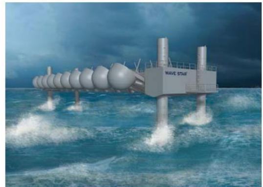
**Figura 43** – Ilustração do dispositivo Wavestar em funcionamento.
