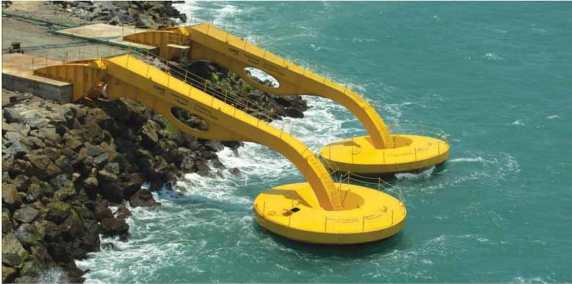
**Figura 18** – Módulos da usina de ondas piloto, desenvolvida pela COPPE/UFRJ no Porto do Pécem.
