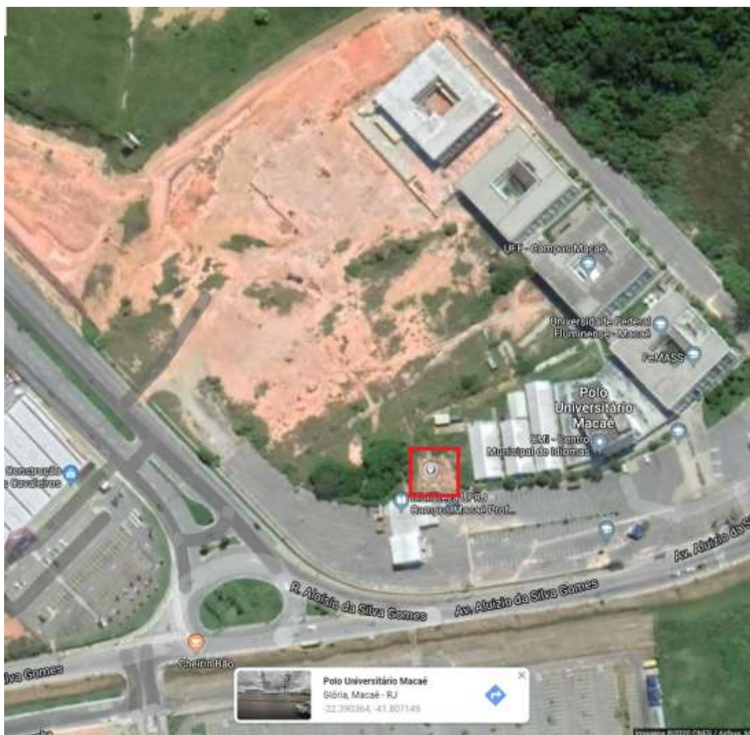
Figura 5 - Imagem Google maps de satélite da UFRJ Campus Macaé, destacando a localização do banheiro wetland em fase de construção. https://www.google.com.br/maps/@-22.3898884,-41.8073921,378m/data=!3m1!1e3
