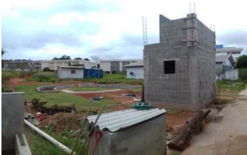
Figura 12 - Etapa da construção quando iniciou o processo de modelagem (parte 1)
