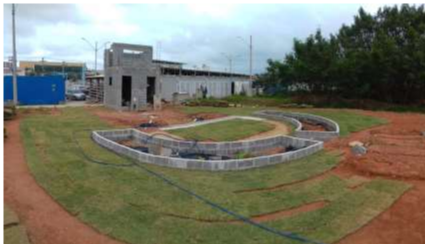
Figura 13 - Etapa da construção quando iniciou o processo de modelagem (parte 2)
