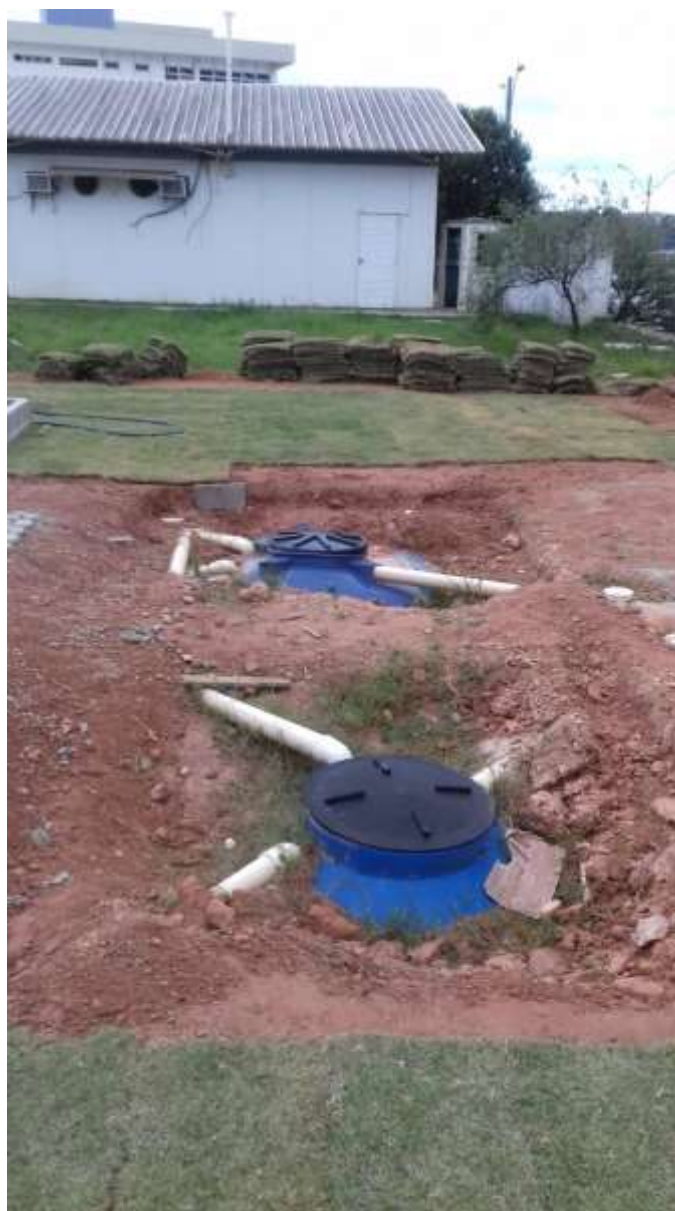
Figura 14 - Tratamento primário por tanques sépticos
