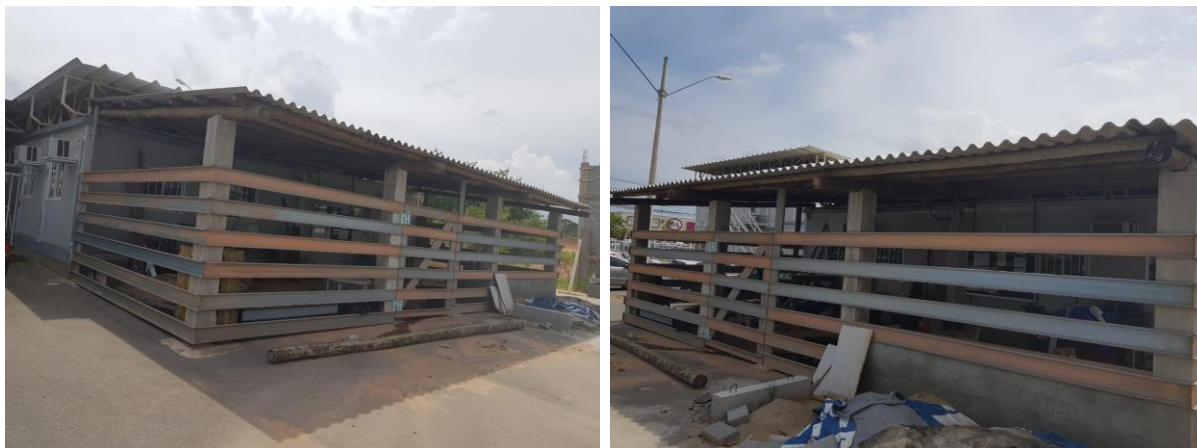
Figura 26: Área externa do laboratório de engenharia civil UFRJ – Macaé
