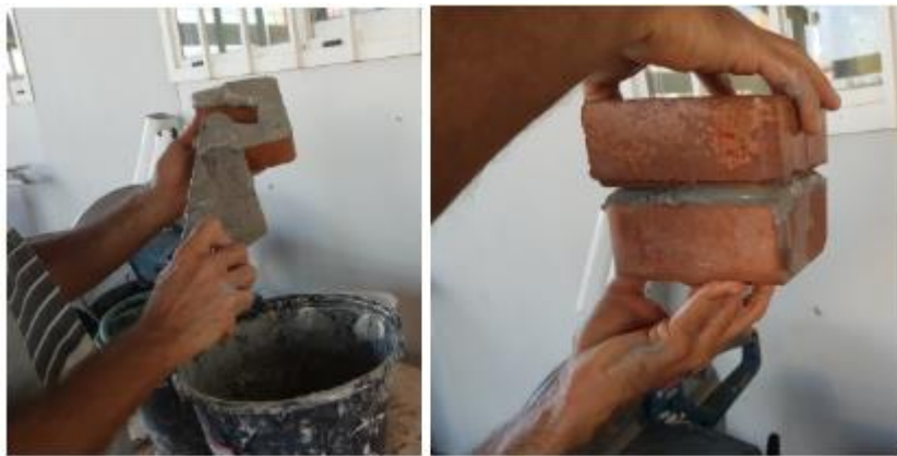
Figura 29: Colocação da pasta de cimento
