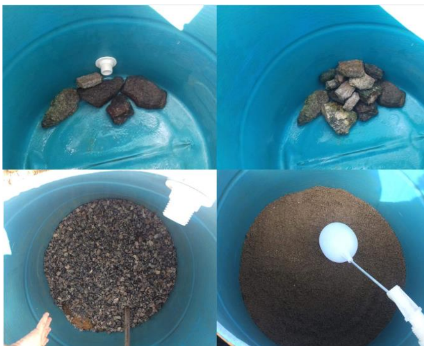
Figura 19: (A) Início da disposição do pedregulho grosso; (B) pedregulho grosso cobrindo tubo de saída; (C) disposição do pedregulho fino; (D) disposição da camada de areia (Fonte: Autora).
