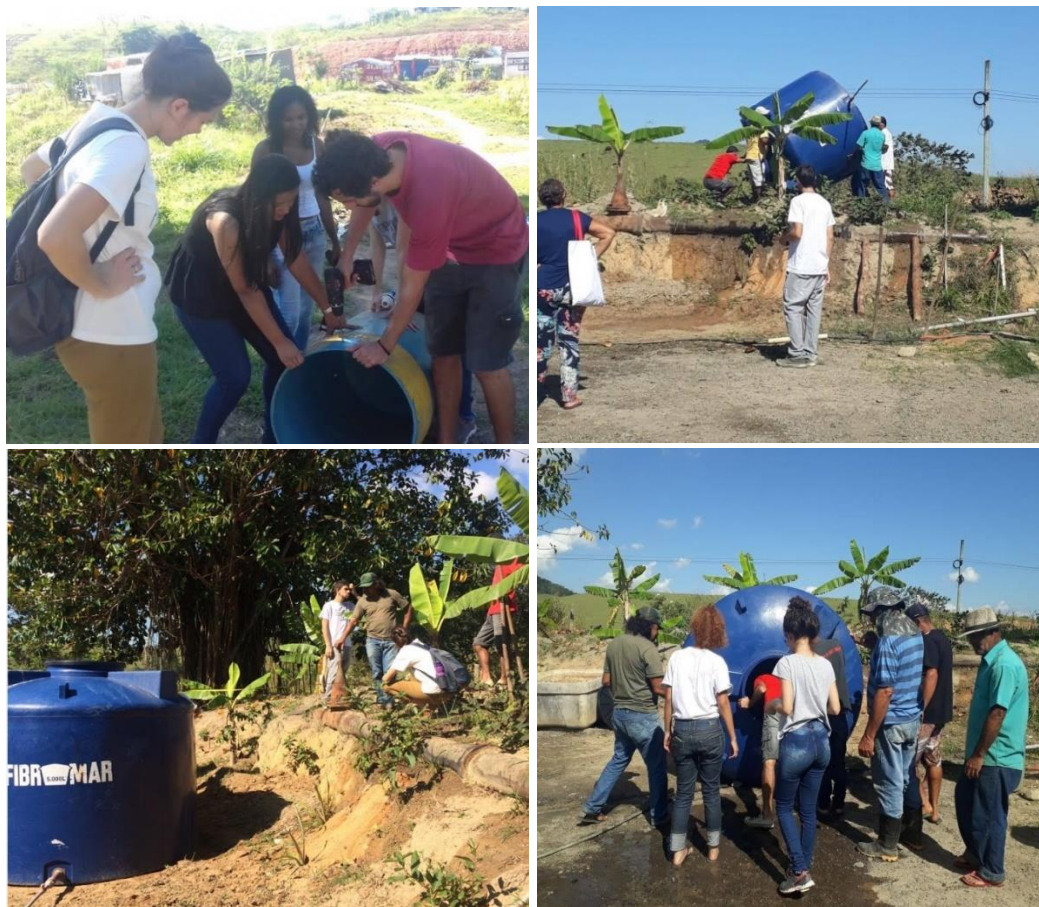
Figura 17: Acampados e estudantes na montagem do sistema hidráulico (Fonte: Autora).
