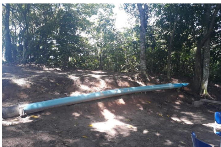
Figura 12: Trecho da adutora do sistema de abastecimento do córrego do Atalaia que atravessa o acampamento Edson Nogueira (Autora).
