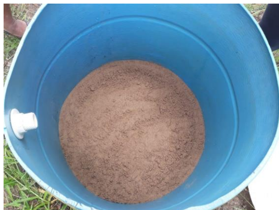
Figura 23: Recolocação da camada de areia fina disposta (Fonte: Autora).
