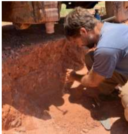
Figura 6.13 – Primeira camada sendo colocada no local antes da compactação.
