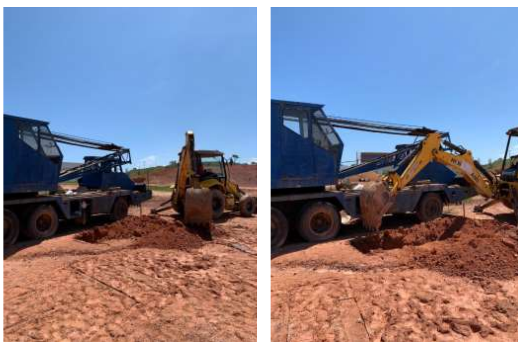
Figura 6.9 – Execução da escavação com retroscavadeira.
