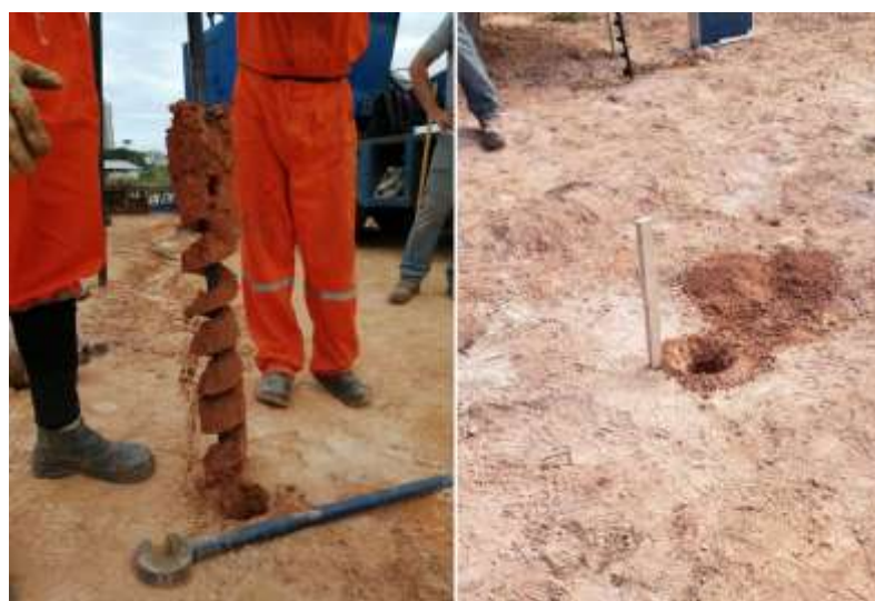
Figura 5.10 – Escavação com trado helicoidal e locação do furo.
