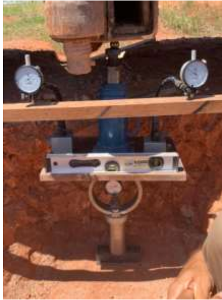
Figura 6.11 – Prova de carga pronta para ser iniciada.
