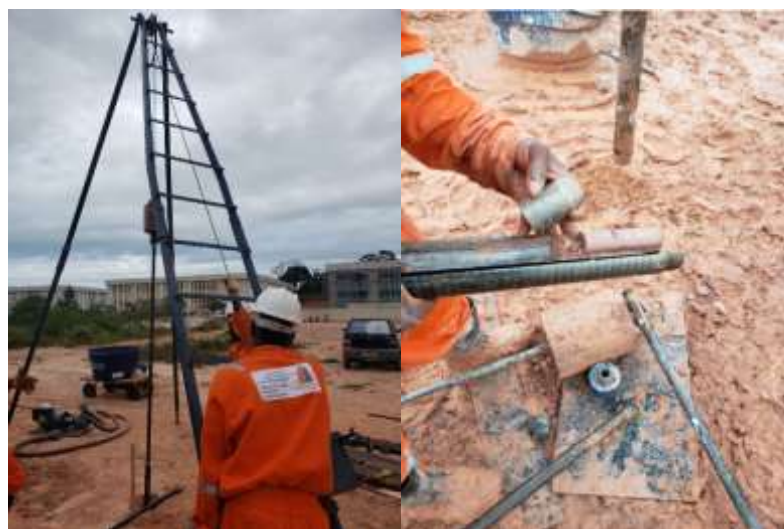
Figura 5.11 – Execução dos golpes com o martelo e coleta de amostra.
