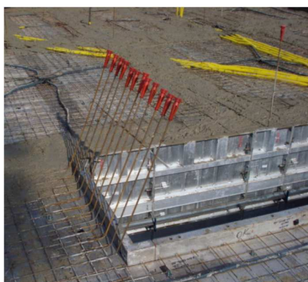
Figura 11: Proteção da armação de espera.
