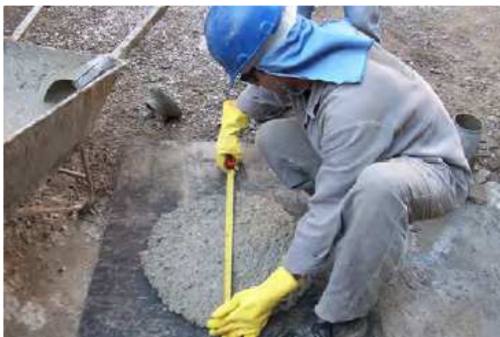
Figura 6: Realização de ensaio de espalhamento.
