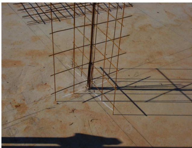
Figura 10: Fixação de armadura de canto.
