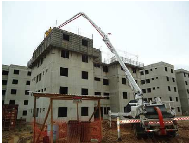
Figura 14: Lançamento de concreto com auxílio de bomba-lança.
