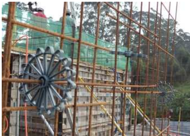
Figura 4: Armadura em telas para parede de concreto.
