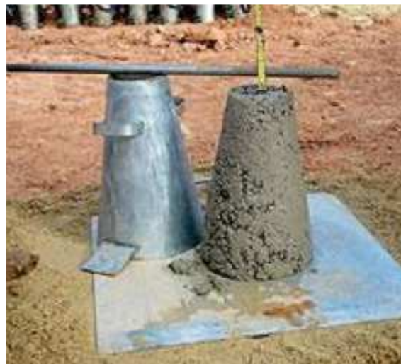
Figura 5: Realização de Slump test .
