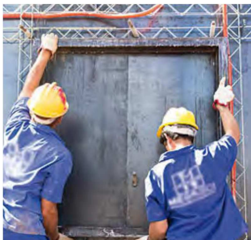
Figura 9: Fixação de gabarito para janela.
