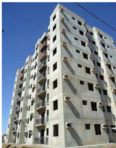
Figura 16: Estrutura executada com Paredes de Concreto à espera de revestimento final.
