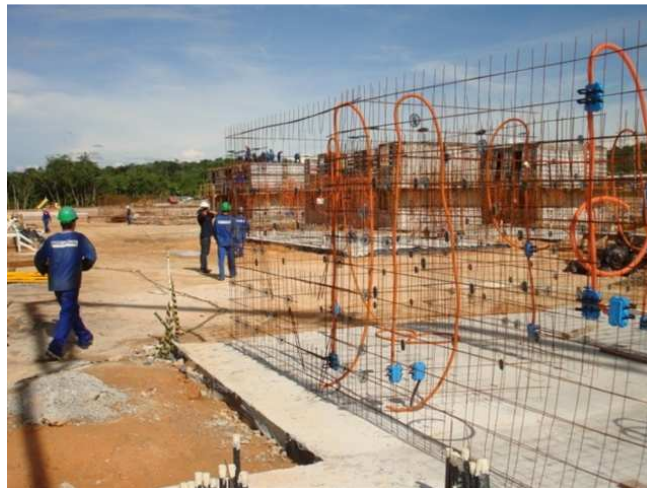
Figura 12: Instalações Prediais fixadas.
