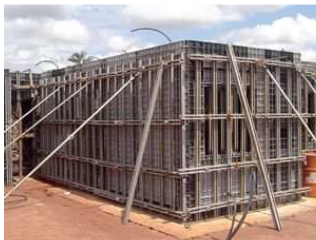
Figura 2: Fôrmas metálicas em contato com compensado.
