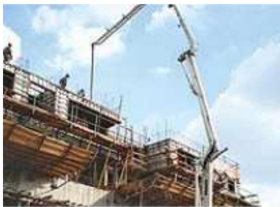
Figura 15: Vibração do concreto com vibrador de mangote.
