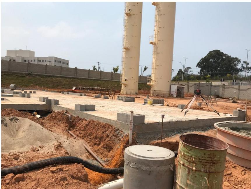
**Figura 14** - Lajão pronto para receber Fiada Zero.
