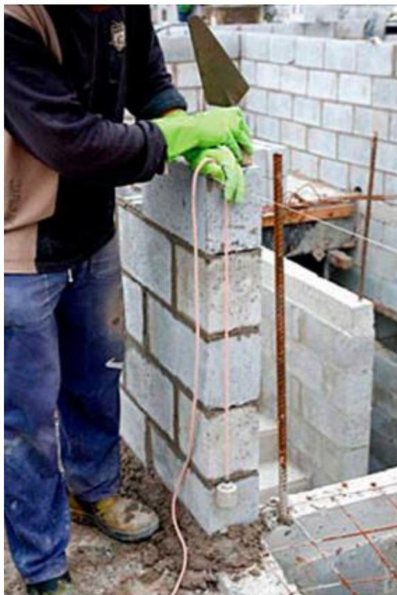
**Figura 72** – Nível e prumo da alvenaria.
