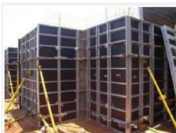
**Figura 7 - Fôrma Metálica com Compensado.**
