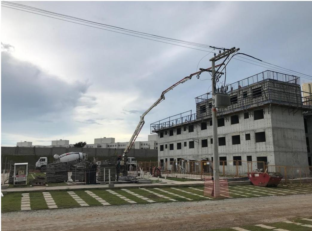
**Figura 81** - Lançamento de concreto.
