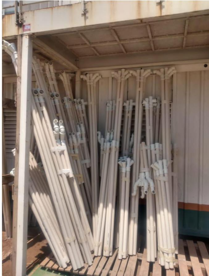
**Figura 28** - Kit hidráulico de esgoto cozinha finalizado.
