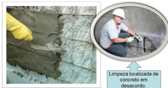
**Figura 51** - Tratamento em paredes com ondulações, utilizando AC III.
