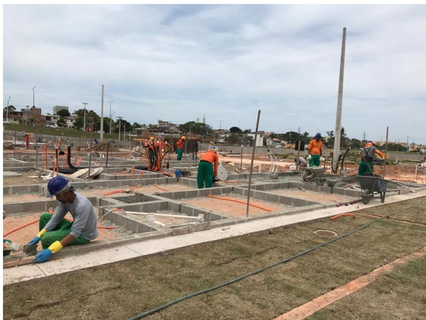
**Figura 15** - Fiada Zero em execução.
