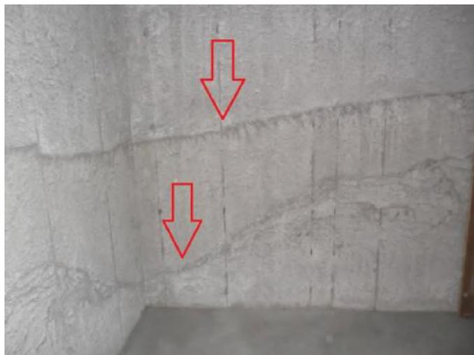
**Figura 52** - Junta de concretagem após aplicação de concreto vencido.
