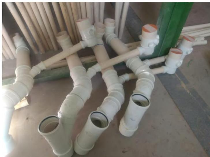
**Figura 29** - Kit hidráulico de esgoto banheiro finalizado.
