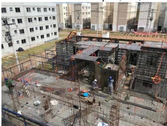
**Figura 82 -** Fôrma em fase de montagem.
