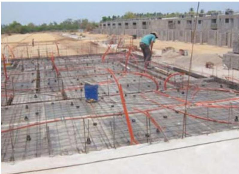
**Figura 37** – Laje após colocação das malhas.
