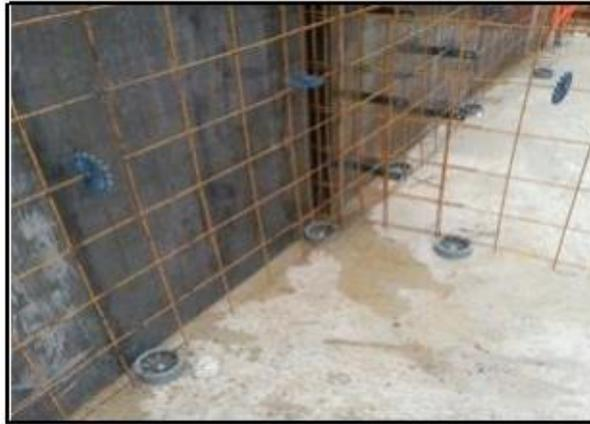
**Figura 21** - Montagem das telas de aço com auxílio de distanciadores para serem mantidas nos eixos.
