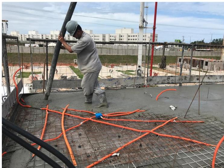
**Figura 44** – Concretagem com concreto auto adensável.
