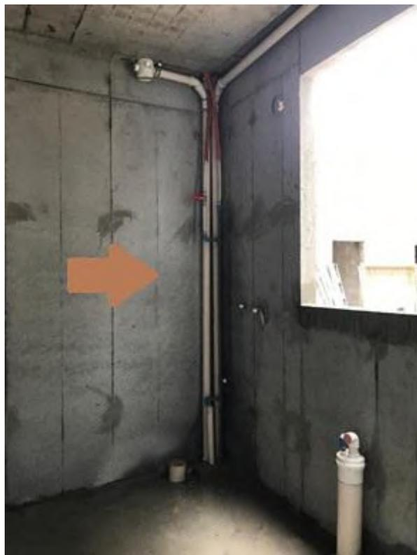
**Figura 26** - Instalação hidráulica de esgoto e água fria montadas na parte externa da Parede de Concreto.
