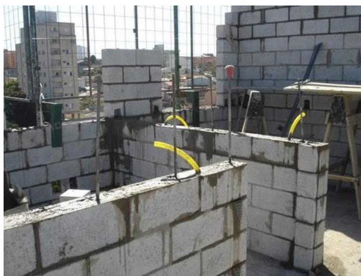
**Figura 61** – Instalações previamente realizadas.
