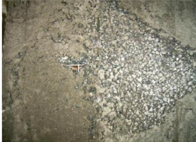
**Figura 50** - Exemplo de imperfeições após desforma.
