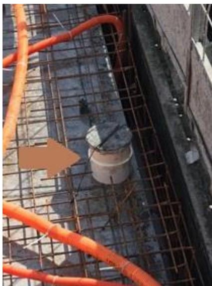
**Figura 27** - Passagem hidráulica em laje.
