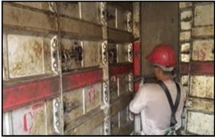
**Figura 46** - Desforma pelos cantos dos cômodos.
