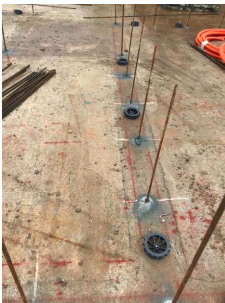
**Figura 20** - Fixação de distanciadores na marcação das paredes.
