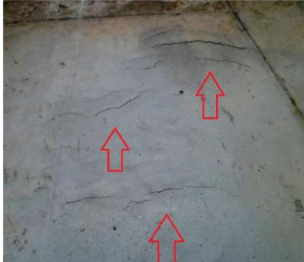
**Figura 49** - Retração hidráulica.
