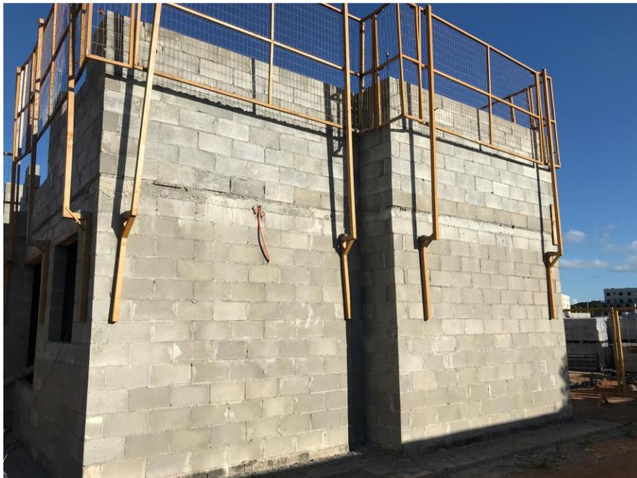
**Figura 89** - Guarda Corpo montado.
