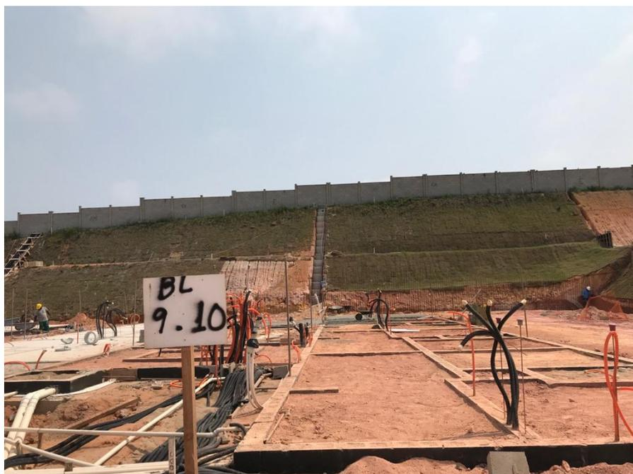
**Figura 16** - Fiada Zero aterrada e compactada.
