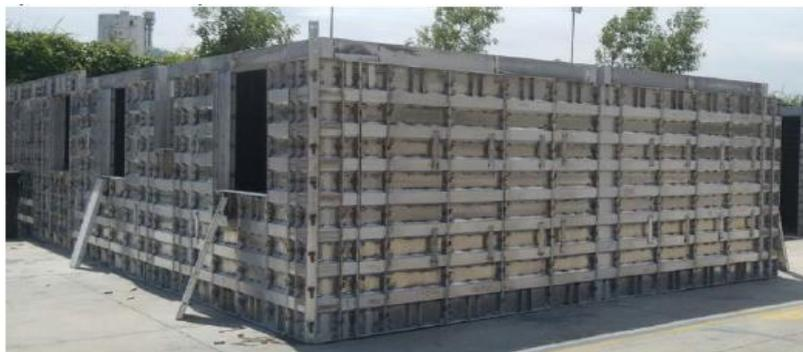
**Figura 5 - Fôrma Metálica: Alumínio.**
