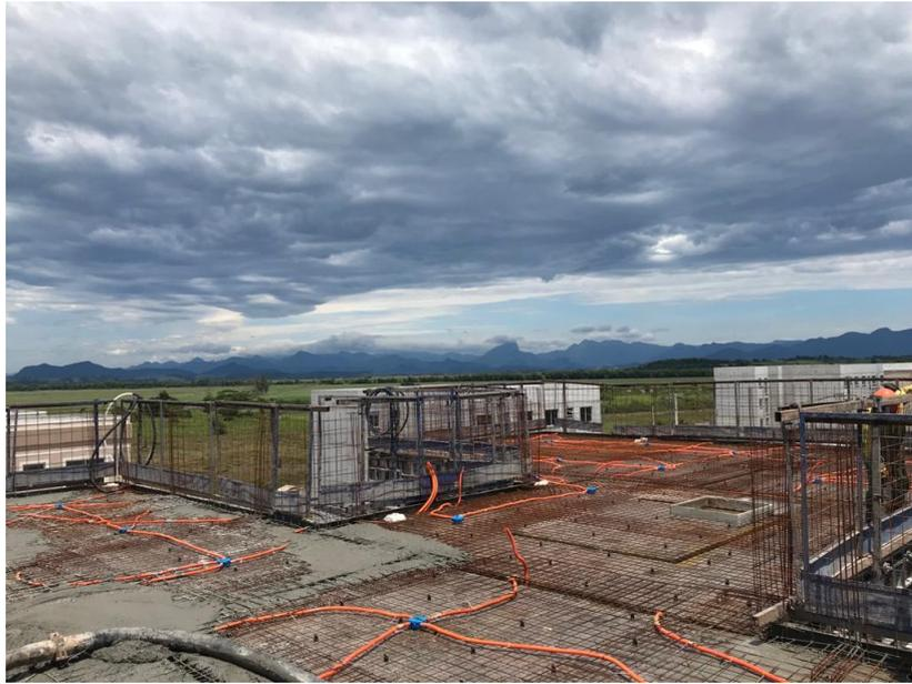
**Figura 80** - Armação da laje finalizada.
