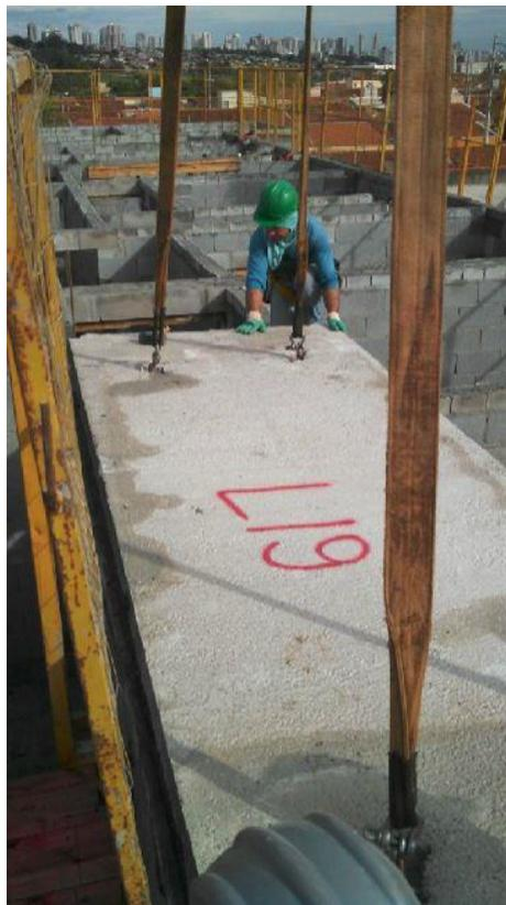
**Figura 65** – Laje pré-moldada do tipo cômodo, moldada com espessura final.
