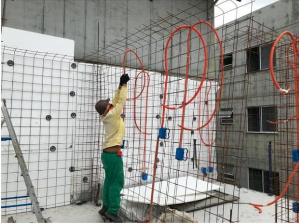
**Figura 9** - Montagem de armação com elétrica e hidráulica embutidas.
