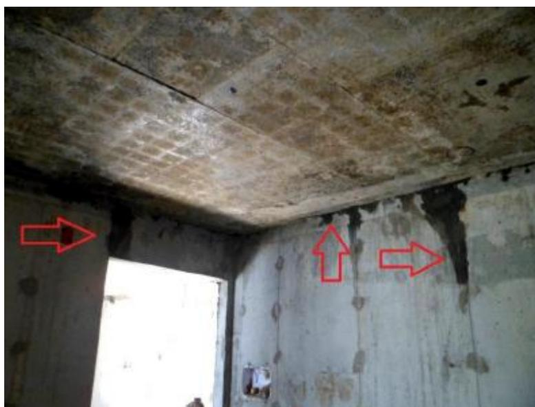
**Figura 53** - Excesso de desmoldante nas paredes.
