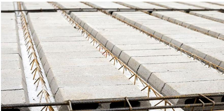
**Figura 67** - Laje Painel Treliçado.
