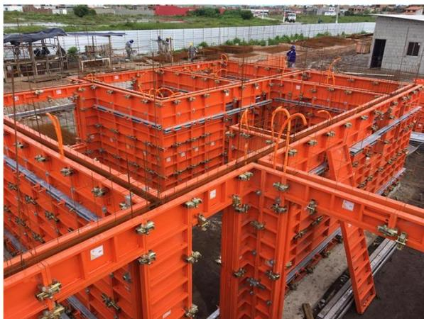
**Figura 6 - Fôrma Metálica – Aço.**
