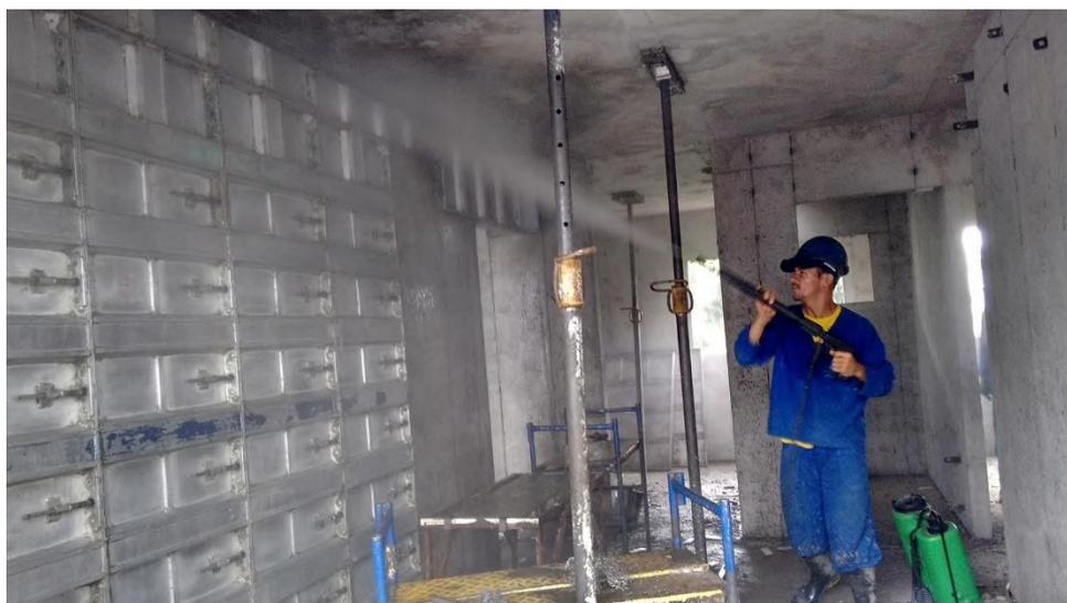
**Figura 45** – Lavagem com lavadora de alta pressão.
