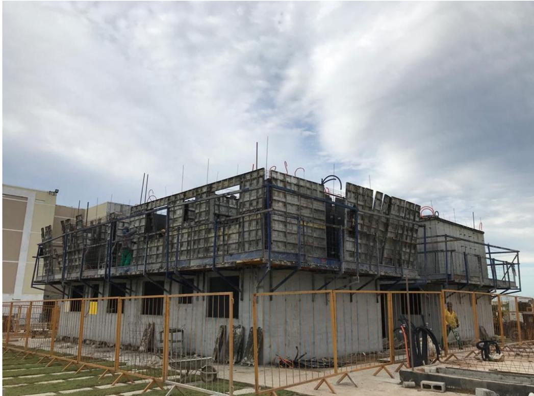
**Figura 48** - Passarela montada ao redor do prédio para fôrma do 2º pavimento.
