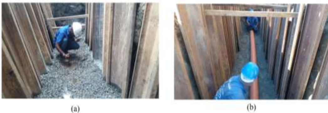
Figura 4.24 - Execução de embasamento para tubulação em PVC. Fonte: autor (2021)
