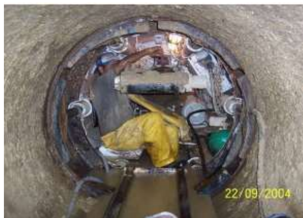
Figura 3.22 – Presença de operador dentro do “shield”. Fonte: DEZOTTI (2008).
