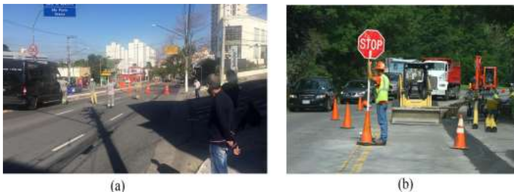
Figura 3.27 - Interdição de via em obra executada pelo método destrutivo. Fonte: https://www.michiganautolaw.com/blog/2014/04/16/sb-896-speeding-construction-zones/ e https://www.girosa.com.br/images/articles/9333/b2ap3_large_WhatsApp-Image-2020-05-11-at-14.45.53.jpeg (acessado em 17/07/2021).
