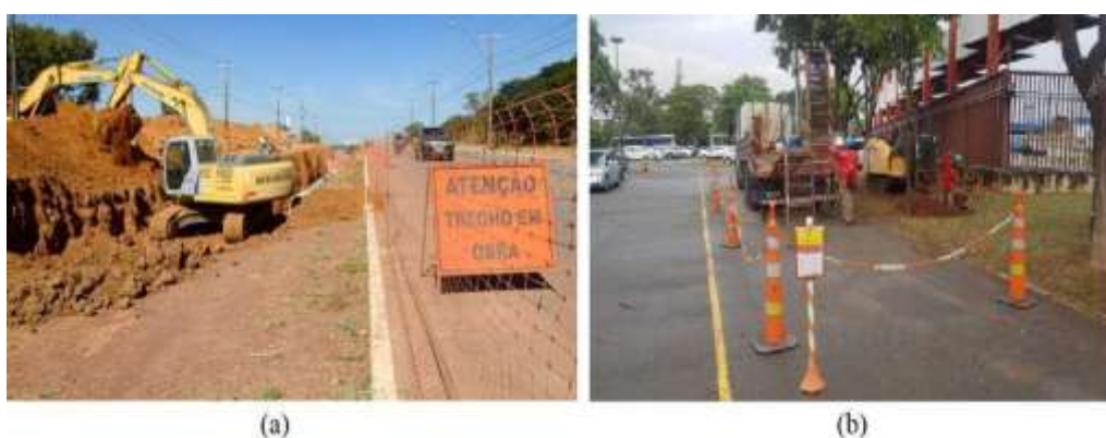
Figura 3.29 – Diferença da geração de resíduos entre o MD e o MND. Fonte: https://www.tocantinsdiario.com.br/2020/07/08/conheca-o-panorama-de-obras-em-andamento-em-palmas-que-ampliarao-acesso-a-infraestrutura-urbana/ e https://innovacaoinfra.com.br/metodos-nao-destrutivos (acessado em 17/07/2021).
