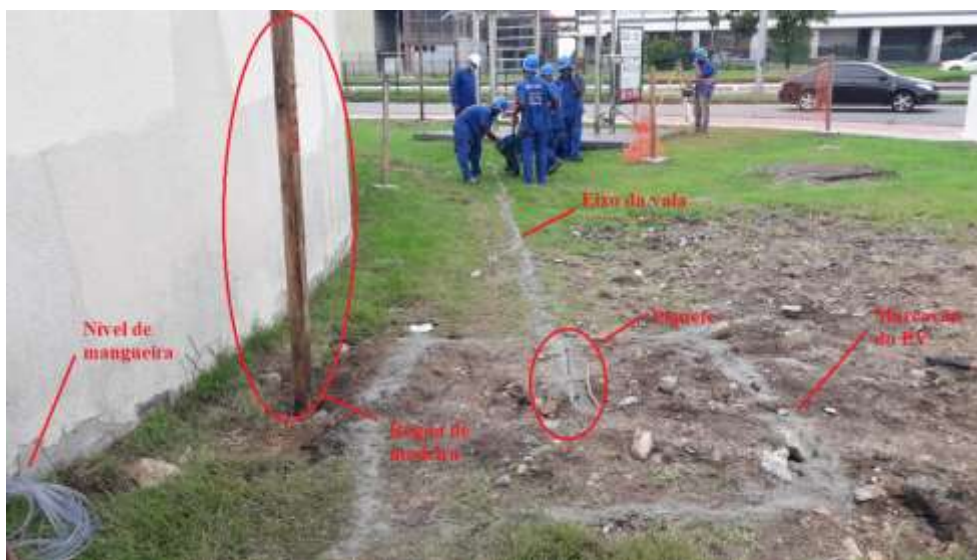
Figura 4.12 - Locação de vala para assentamento de tubulação em trecho da Av. Abelardo Bueno esquina com rua Francisco de Paula.
