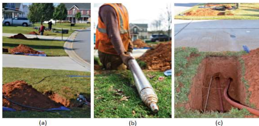
Figura 3.12 - Escavação de poços de visita, perfuratriz a percussão e rede instalada. Fonte: adaptado de HERRERA (2017).
