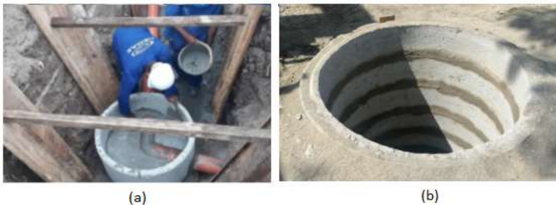
Figura 4.27 - Execução de Poço de Visita em rede coletora na Av. Abelardo Bueno.
