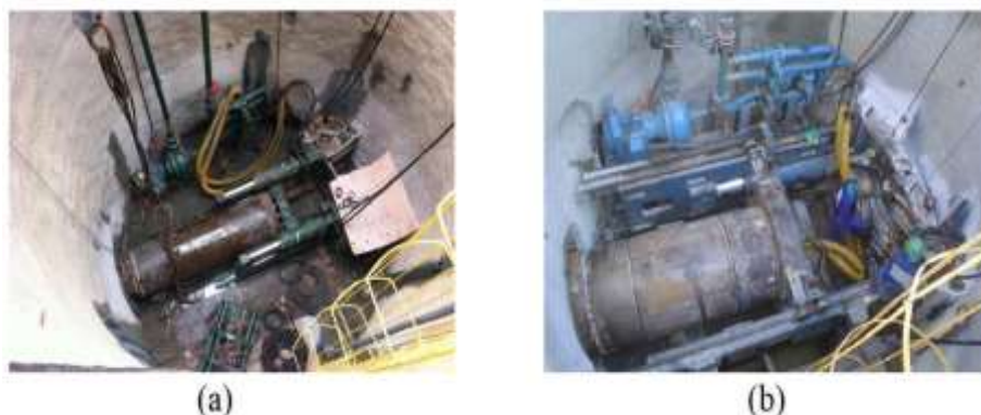
Figura 3.23 – Aplicação do “ pipejacking ” em obra de saneamento no município do Rio de Janeiro. Fonte: CEDAE (2012).
