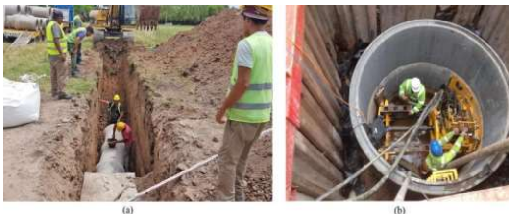
Figura 3.30 – Comparação entre MD e MND com relação à segurança do trabalho. Fonte: https://www.olavarria.gov.ar/en-el-barrio-san-lorenzo-avanza-la-construccion-del-nuevo-conducto-pluvial/ e https://www.trenchlessolutions.co.uk/30m-pilot-bore-at-chadderton-police-station/ (acessado em 17/07/2021).
