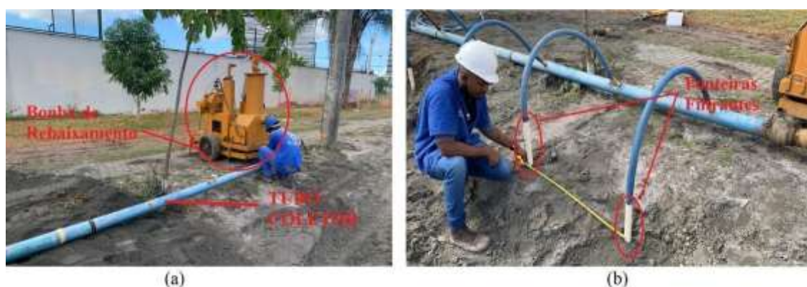
Figura 4.15 – Montagem e funcionamento do sistema de ponteiras filtrantes em obra de esgotamento sanitário.
