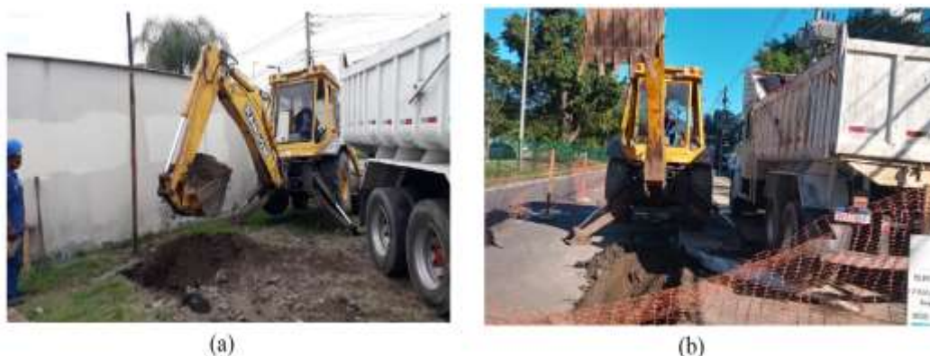
Figura 4.19 - Escavação de vala com retroescavadeira em intervenções na rua Francisco de Paula e Av. Abelardo Bueno.
