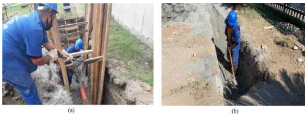
Figura 4.28 - Reaterro de vala. Fonte: autor (2021).
