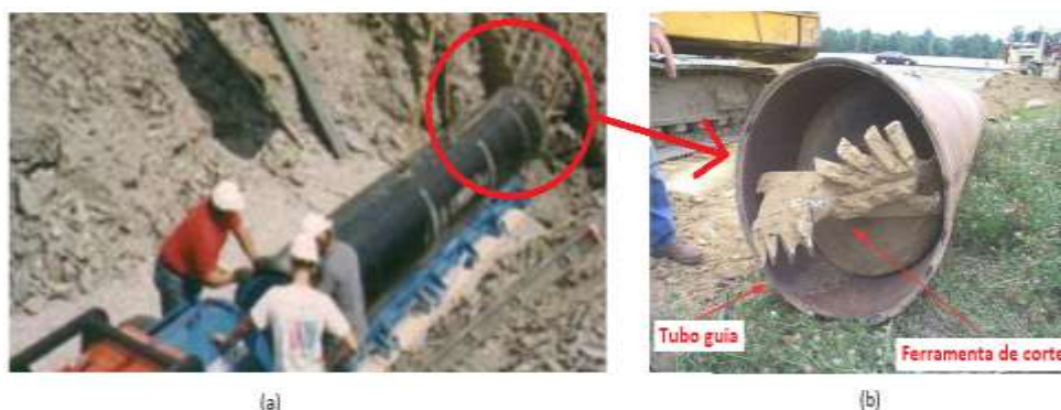
Figura 3.15 - Perfuração por cravação de tubo com extremidade aberta com o sistema de rosca sem fim. Fonte: adaptado de ABRATT (2016).
