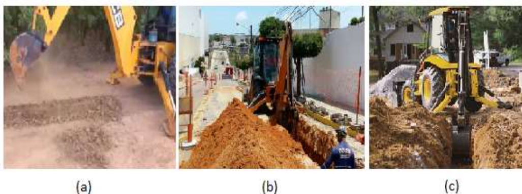
Figura 3.4 - Retroescavadeira sendo utilizada para abertura de vala. Fonte: http://www.brasil.geradordeprecos.info/espacos_urbanos/Preparacao_do_terreno/Movimento_de_terras_e_m_obra_civil/Escavacoes/Escavacao_de_valas_com_meios_mecanicos_0_0_3_0_0_0.html#gsc.tab=0 (acessado em 26/06/2021 e Silva, 2019).
