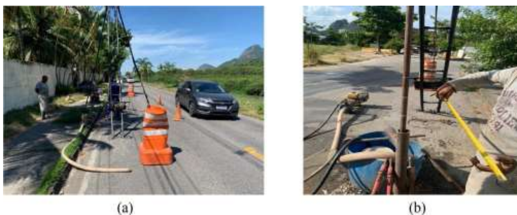
Figura 4.7 - Execução de sondagem a percussão na Rua Francisco de Paula, Jacarepaguá.
