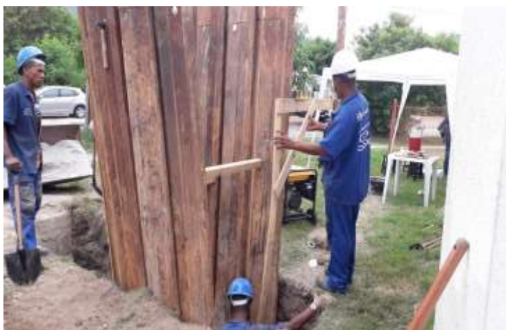
Figura 4.22 - Aplicação do método de cruzetamento para regularização do fundo da vala.
