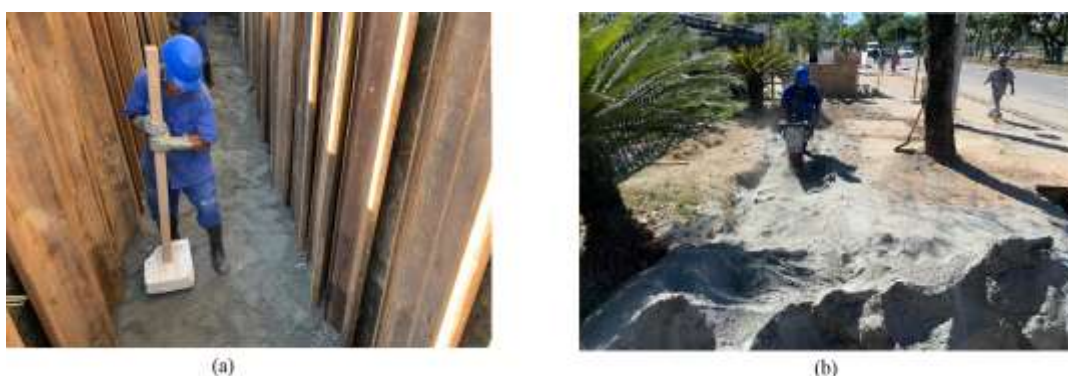
Figura 4.29 - Compactação manual e mecânica em reaterro com pó de pedra.
