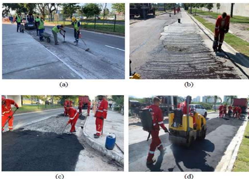
Figura 4.30 -Recomposição do pavimento asfáltico em trecho de rede executado em pista.
