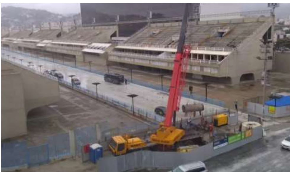
Figura 3.28 - Intervenção em trecho realizado em MND. Fonte: https://revistaoe.com.br/passarelli-conclui-obras-rio-de-janeiro/ (acessado em 17/07/2021).
