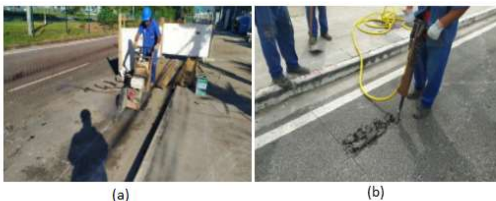
Figura 4.17 - Remoção de pavimentação asfáltica em trecho executado na Av. Abelardo Bueno.
